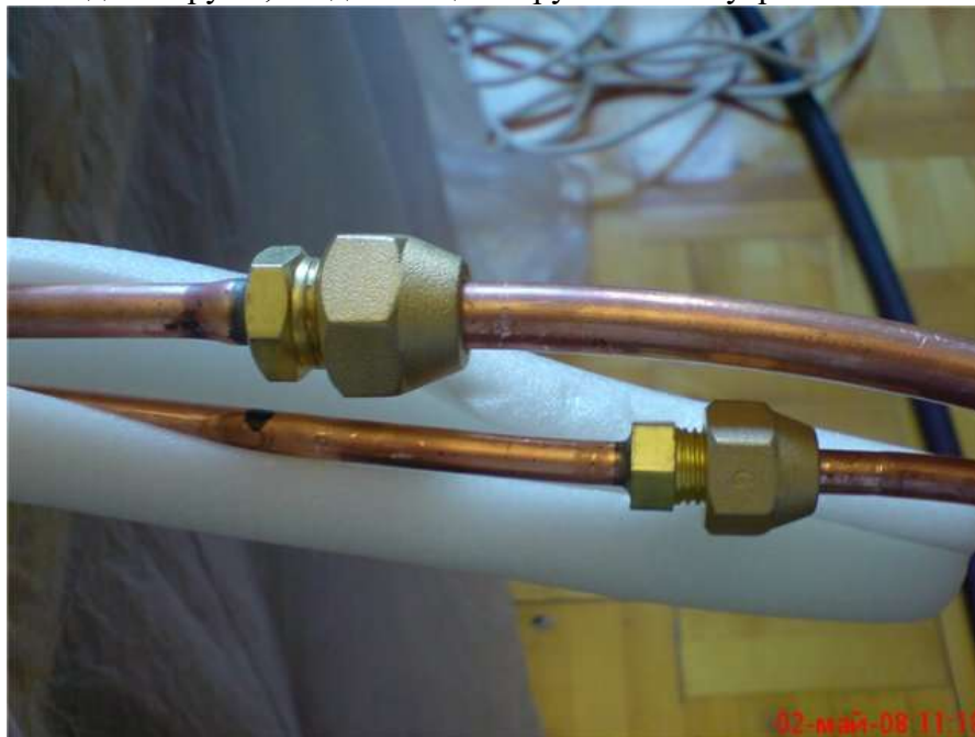
Рисунок 4 Штуцерное соединение кондиционера
